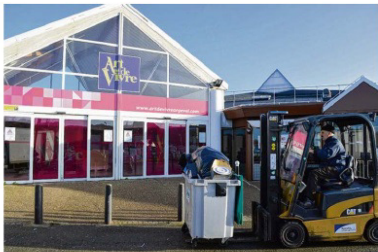
Quatre ans de travaux de démolition reconstruction devraient se dérouler au centre commercial Art de Vivre dès 2020.
